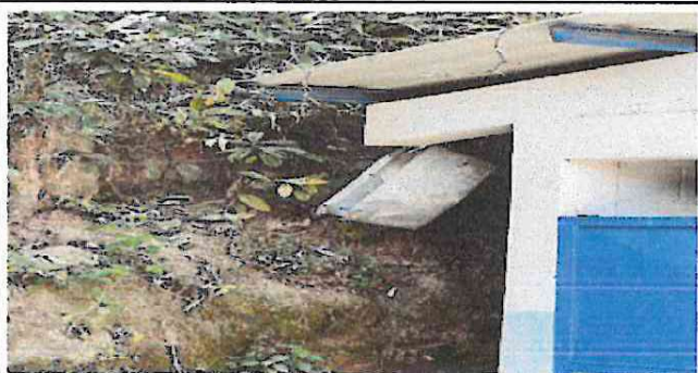
Foto 5: aquí observamos los canales deteriorados, doblados y rotos cuando llueve cae toda el agua al corredor.
