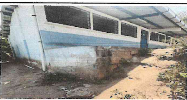
Foto 12: ahí se observan restos del muro perimetral que sufrio daños a causa de las lluvias
