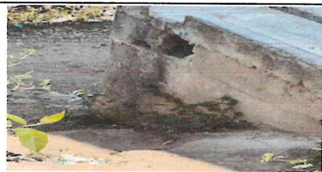
Foto 11: de esta parte se observa el agujero que dejo una de las columnas del muro de contencion.
